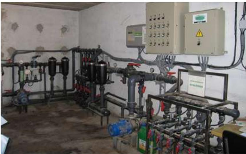
**Fotografía 2.** Cabezal automatizado de fertirrigación.
